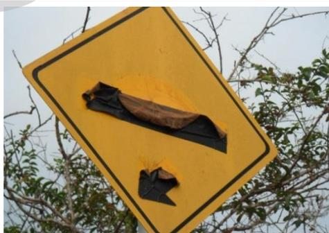
Foto diurna, iluminação natural, tirada de dentro do veículo. Situação: lombada em estrada rural. Percebe-se que só os símbolos foram atacados, a borda também preta se mantém em boas condições evidenciando possível execução deficiente da placa.
