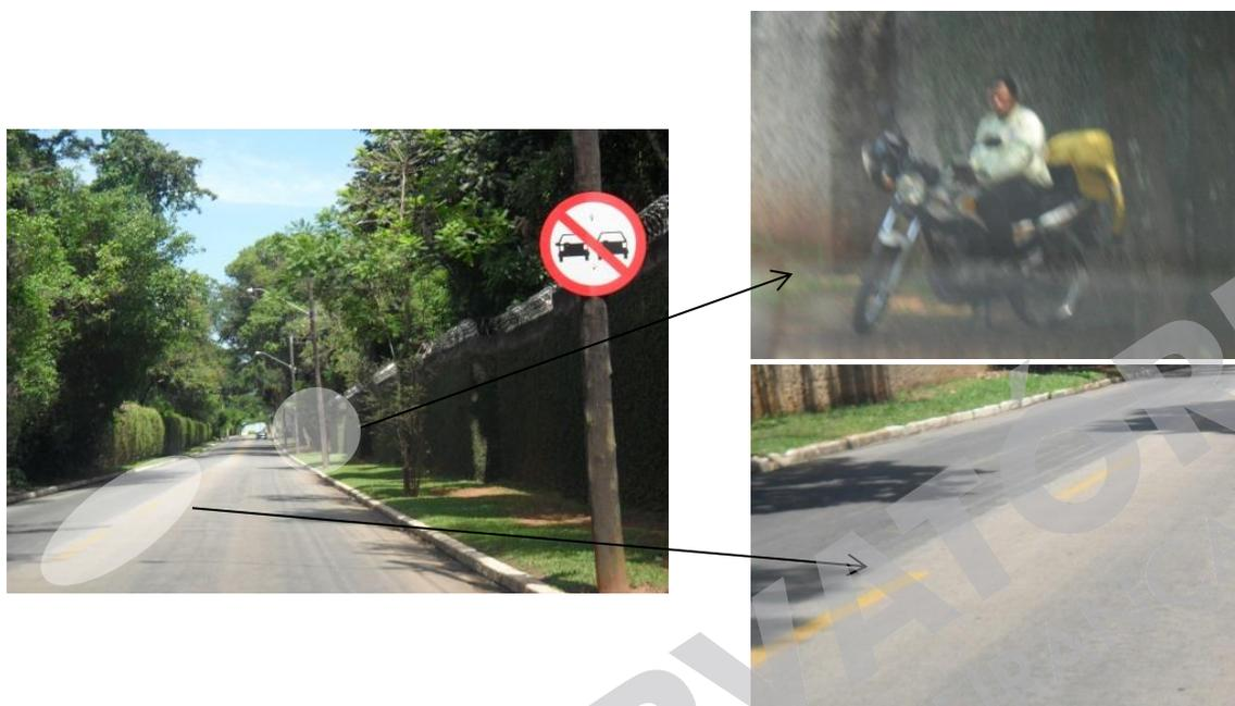
Conjunto de fotos diurnas, tiradas de dentro do veículo com iluminação natural. Situação: Na foto inferior à direita, percebe-se que a sinalização horizontal permite a ultrapassagem. Na foto à esquerda, percebe-se que durante a ultrapassagem, permitida pela sinalização horizontal, o motorista se depara com a placa de “Proibido Ultrapassagem”, mesmo com a sinalização horizontal continuando a informar esta permissão.
