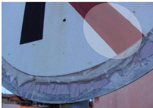
Foto ao entardecer com iluminação natural reduzida, a pé. Situação: placa de proibição de curva a direita (reformada possivelmente fora da norma, dado ao material e cores usados – veja destaque) em cruzamento de bairro urbano perigoso por ter suas ruas dispostas em ângulos que dificultam a visibilidade.
