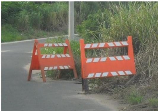
Foto diurna, com iluminação natural, de dentro do veículo, trafegando em velocidade reduzida. Situação: Cavaletes identificando um assoreamento da borda de pista.
