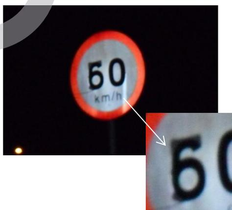
Foto Noturna, iluminada pelos faróis e pela iluminação pública. Situação: placa refletiva de 60Km/h alterada, utilizando-se de uma inscrição anterior de 50Km/h.
