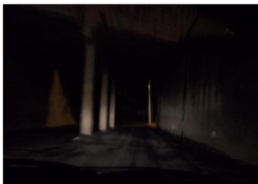
Fotos noturnas, imagem com iluminação pública precária mesmo utilizando todas alternativas de faróis do veículo (altos e de neblina). Situação: Retorno e acesso a shopping center, postos de serviços e parques temáticos, no Km 72 da Rodovia dos Bandeirantes, sem identificação da curva, delineadores, sinalização horizontal, iluminação e asfalto em péssimas condições.
