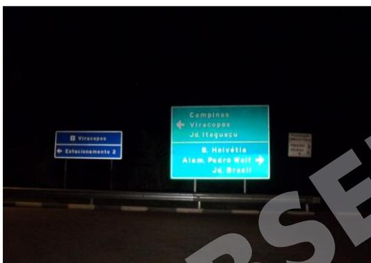
Foto noturna, iluminada pelos faróis e tirada de dentro de veículo. Situação: a sinalização foi produzida com grandes dimensões, para permitir o entendimento das informações.
