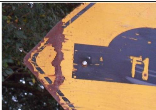
Foto diurna, iluminação natural, à pé. Situação: placa instalada sem distância lateral da estrada, permitindo a batida de carrocerias de caminhões e ônibus.
