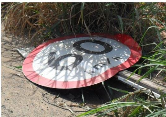
Foto diurna, de dentro do veículo. Situação: acesso à marginal de rodovia. Possivelmente foi removida por acidente ou manobra de veículo de grande porte (marcas de pneus nas proximidades).
