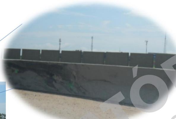
Fotos diurnas, iluminação natural, de dentro do veículo em movimento. Situação: Viaduto de retorno ao aeroporto de Viracopos, com 2 faixas e sem identificação da curva, delineadores ou qualquer outra sinalização. São visíveis marcas de acidentes e restos de peças de veículos pelo chão.
