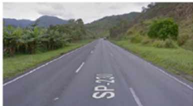
Antes da intervenção a partir dos resultados obtidos no simulador de direção – sinalização existente antes da curva no km 514+100 m da Rodovia Régis Bittencourt.
