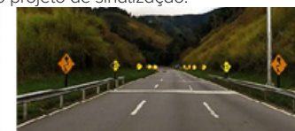
Depois da intervenção a partir dos resultados obtidos no simulador de direção – alteração da sinalização antes da curva no km 510+600 m da Rodovia Régis Bittencourt.
