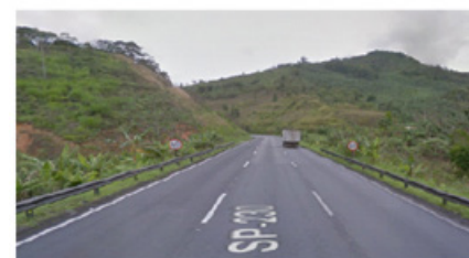
Antes da intervenção a partir dos resultados obtidos no simulador de direção – sinalização existente antes da curva no km 514+650 m da Rodovia Régis Bittencourt.
